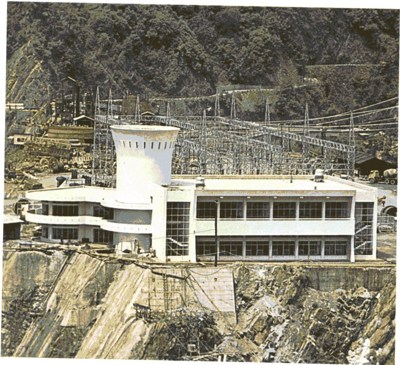
Gennaio 1975 Vista dell'edificio di controllo e della sottostazione.
