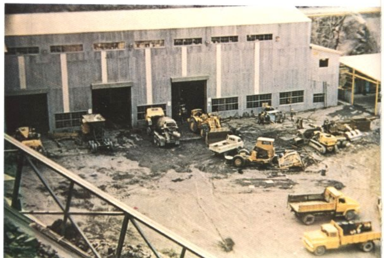
Officina e magazzino del cantiere.
