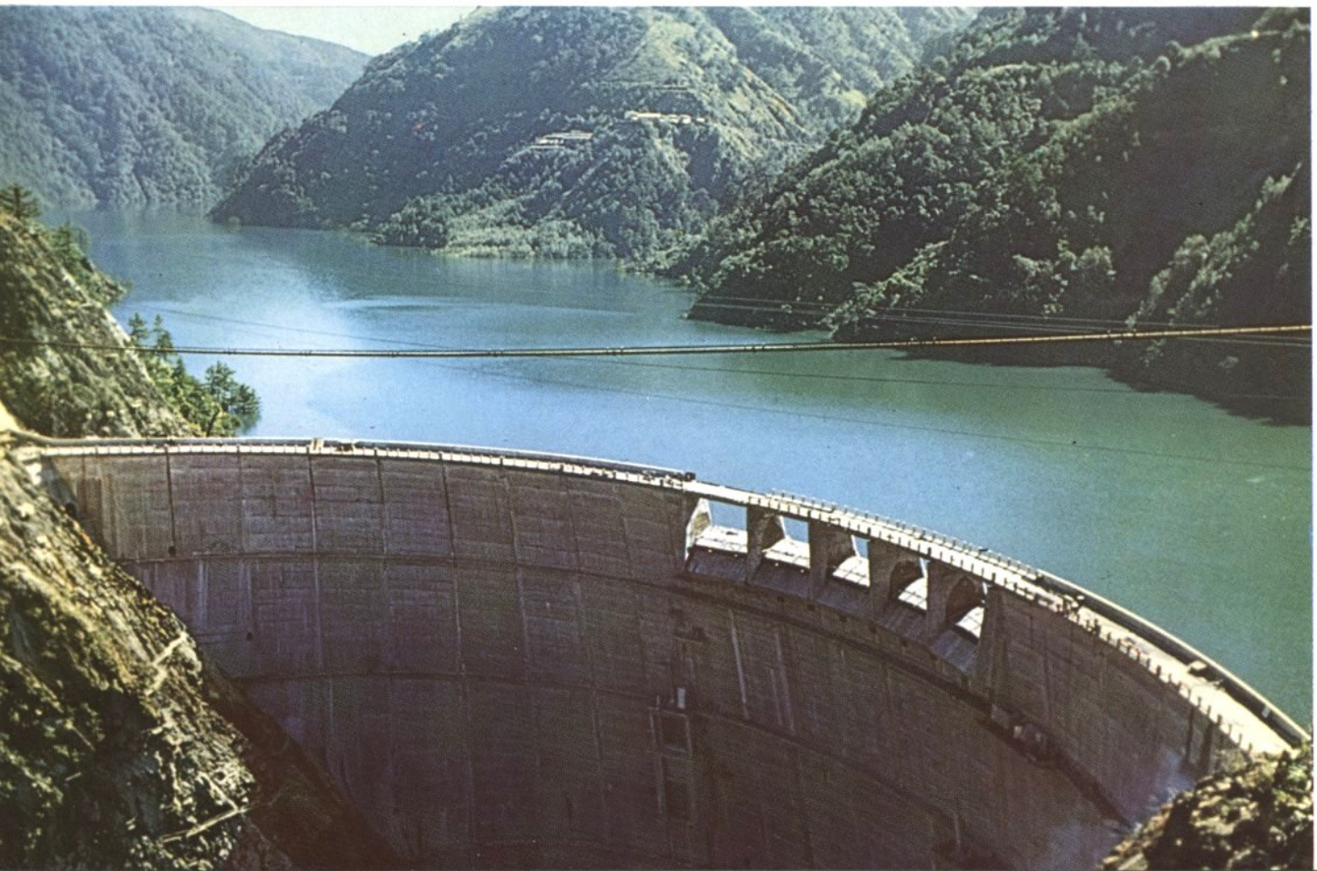
Vista da valle della diga con le aperture sfioranti ultimate.
