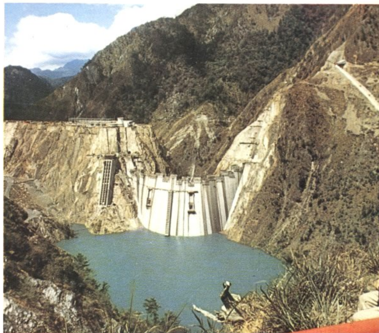
Marzo 1974 La diga vista da monte.
