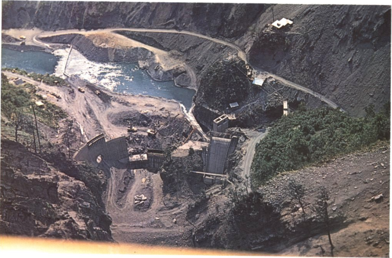
Vista dell'avandiga di monte (h 46 m) in costruzione.
