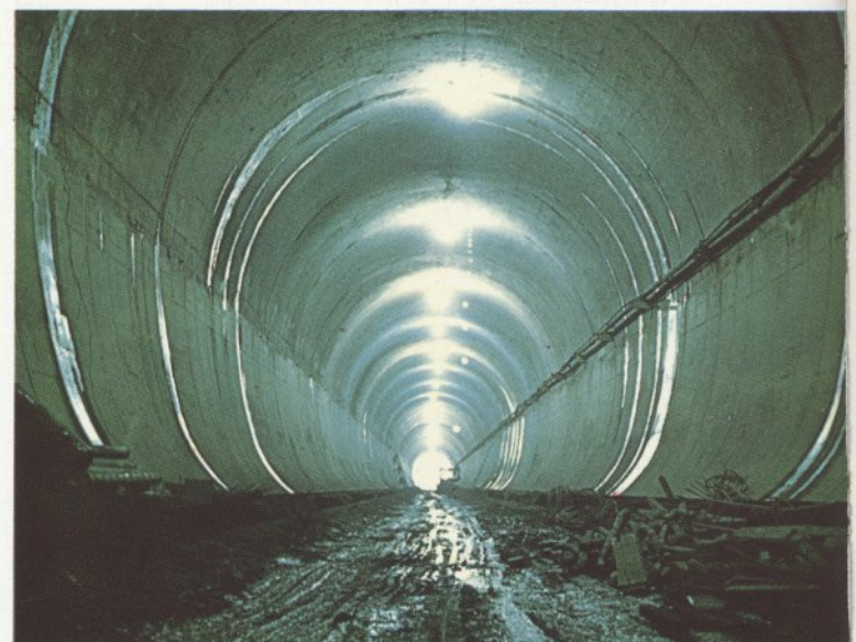
La galleria dello sfioratore di 11,60 m di diametro e per una portata di 3.200 m 3 /s.
