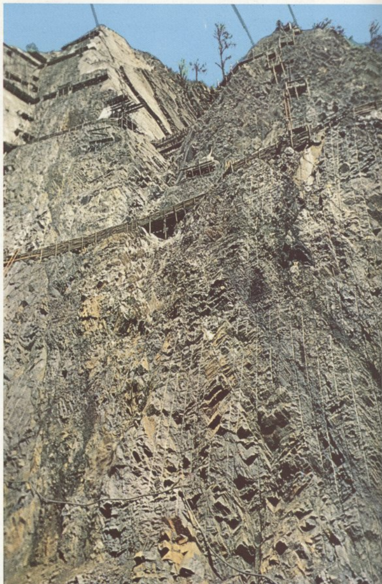
Una parete degli scavi diga ricavata con sistema presplitting e sostenuta artificialmente con tiranti (« tendons » e « monostrands »).
