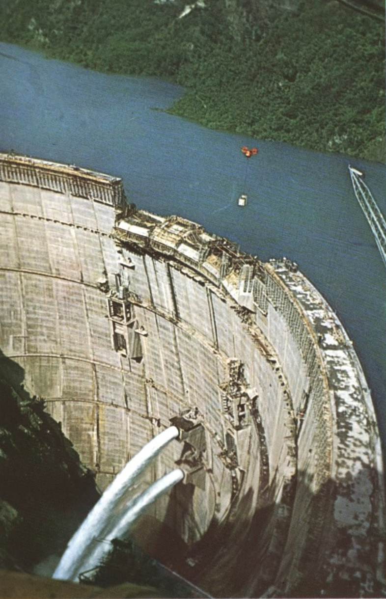
Le opere di scarico nella diga: le aperture sfioranti in fase di esecuzione; i due scarichi di mezzo fondo; le due valvole Howell Bunger (in funzione).
