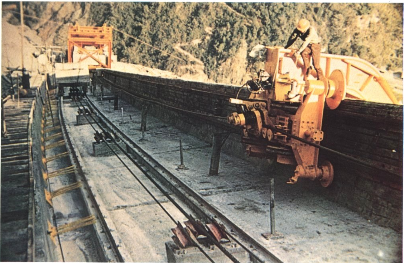
Particolare della via di corsa: si notano a destra uno dei minicar, a sinistra i tiranti di ancoraggio della via di corsa alla roccia.
