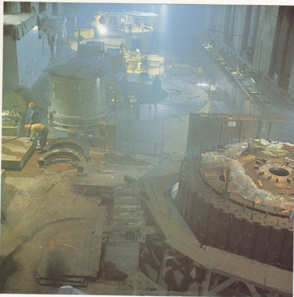
Centrale in caverna, 3 gruppi da 78 MW. Montaggio parti elettromeccaniche.
