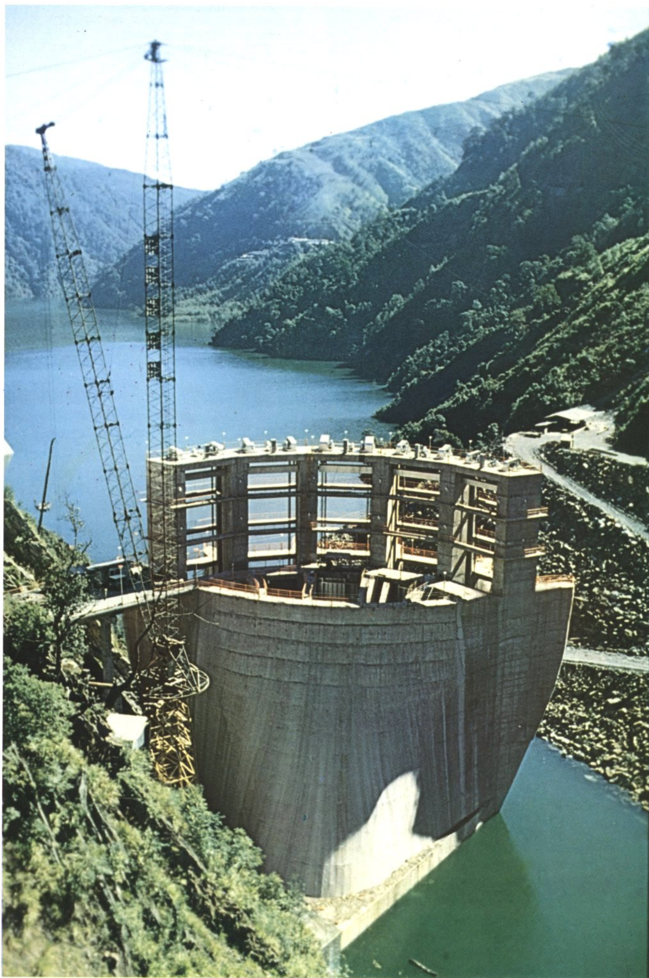
L'imbocco dello sfioratore con le cinque paratoie da 9,35 m di larghezza.
