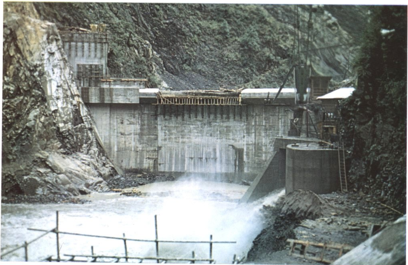
Controdiga di valle (h 43 m) e sbocco della galleria di deviazione (700 m 3 /s).
