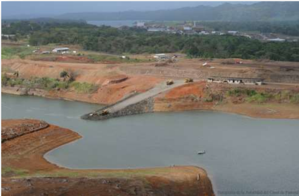
Costruzione del nucleo con il Gatun proveniente dallo scavo del canale di approccio
