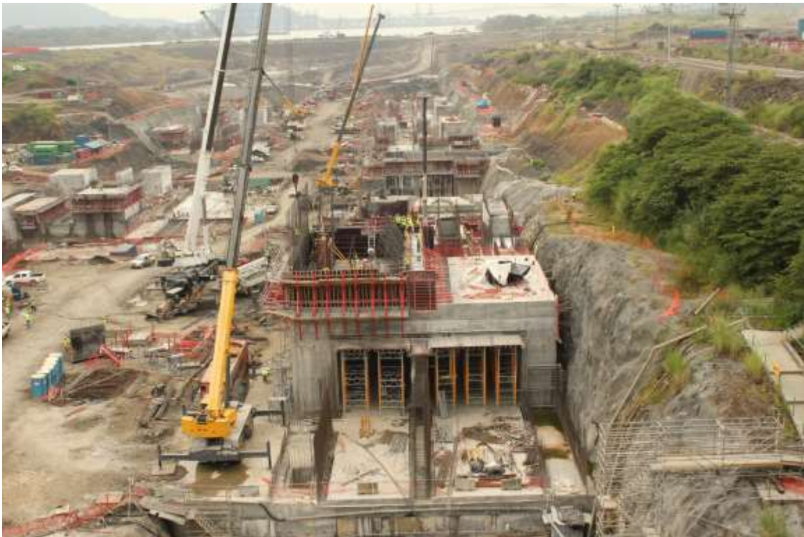
Vista delle gallerie idrauliche dentro i monoliti che riforniranno di acqua il canale via i conduit che collegano il canale stesso con i bacini di accumulo.
