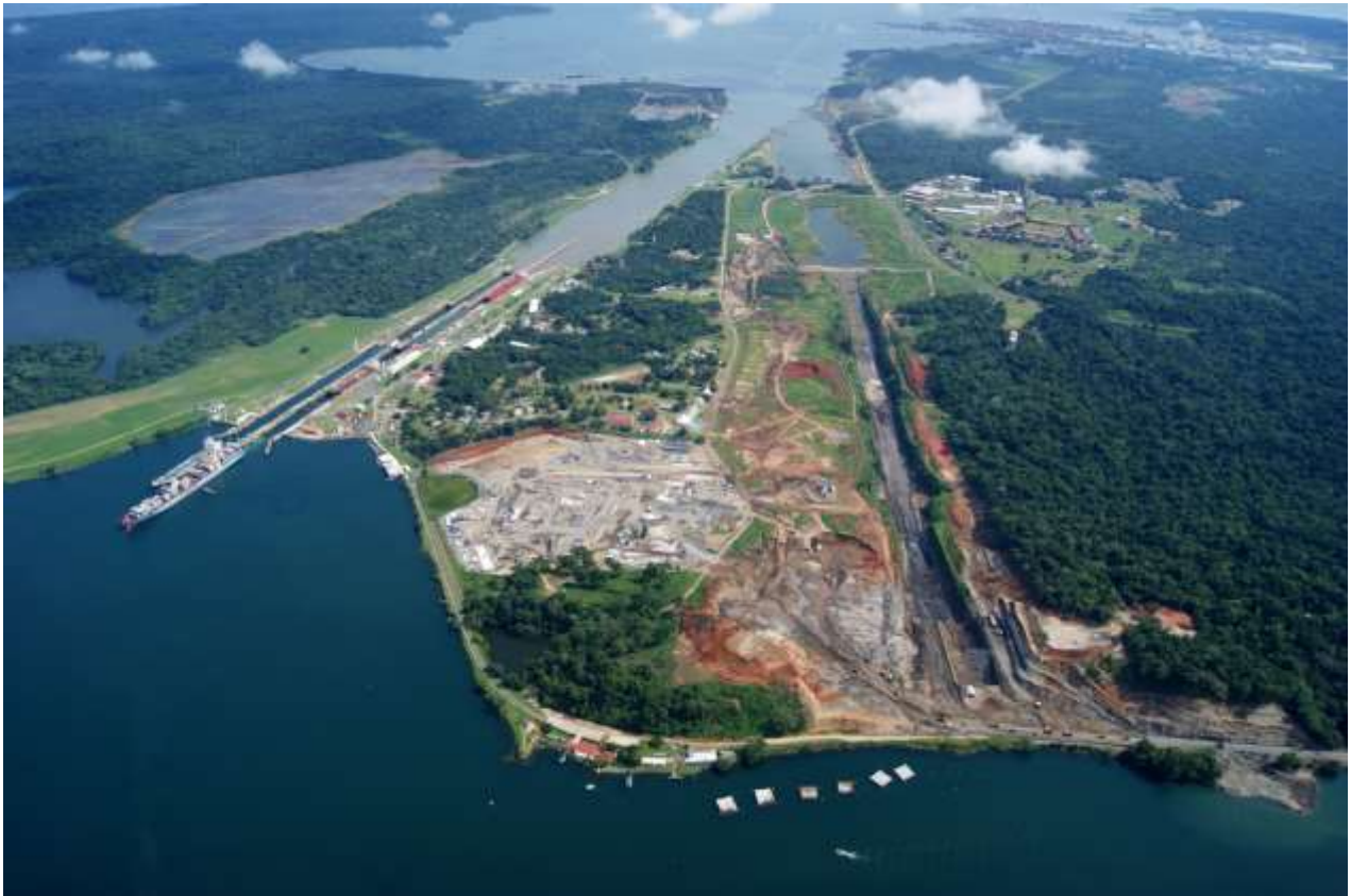
Foto del mese di Agosto 2010 con il canale esistente, l'area industriale ed il nuovo canale con gli scavi in corso
