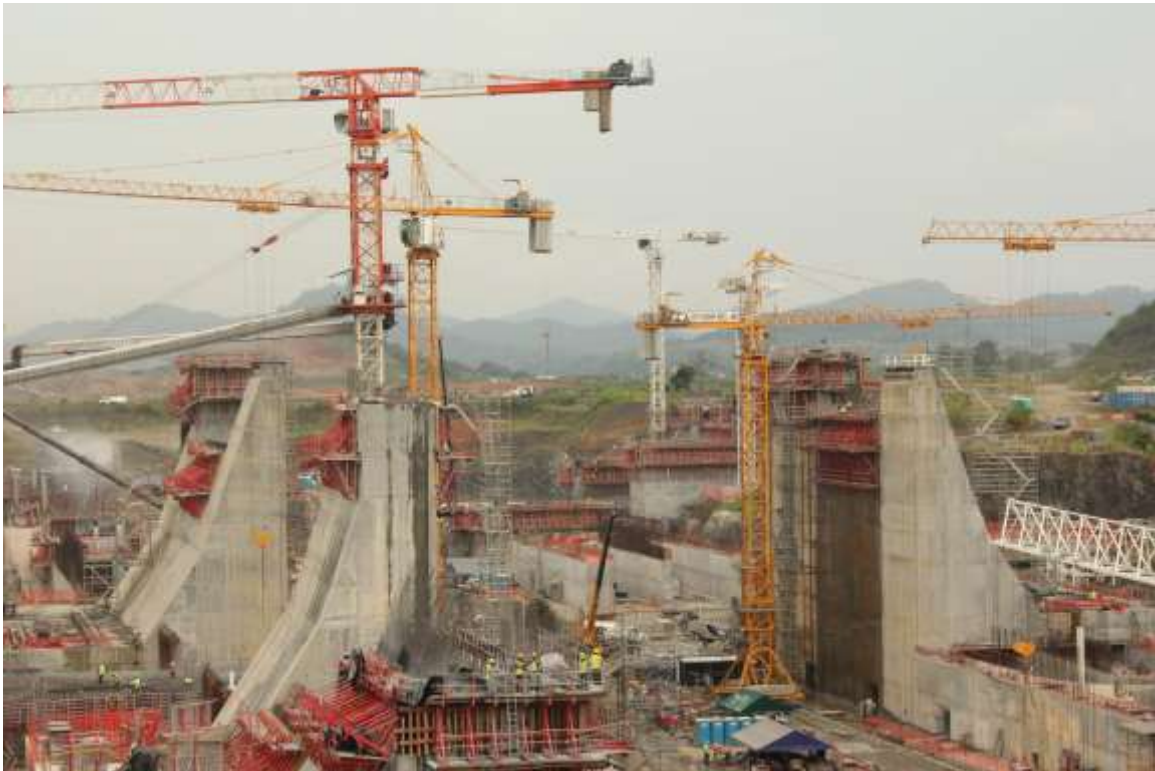
I monoliti del canale e le strutture cominciano a prendere forma
