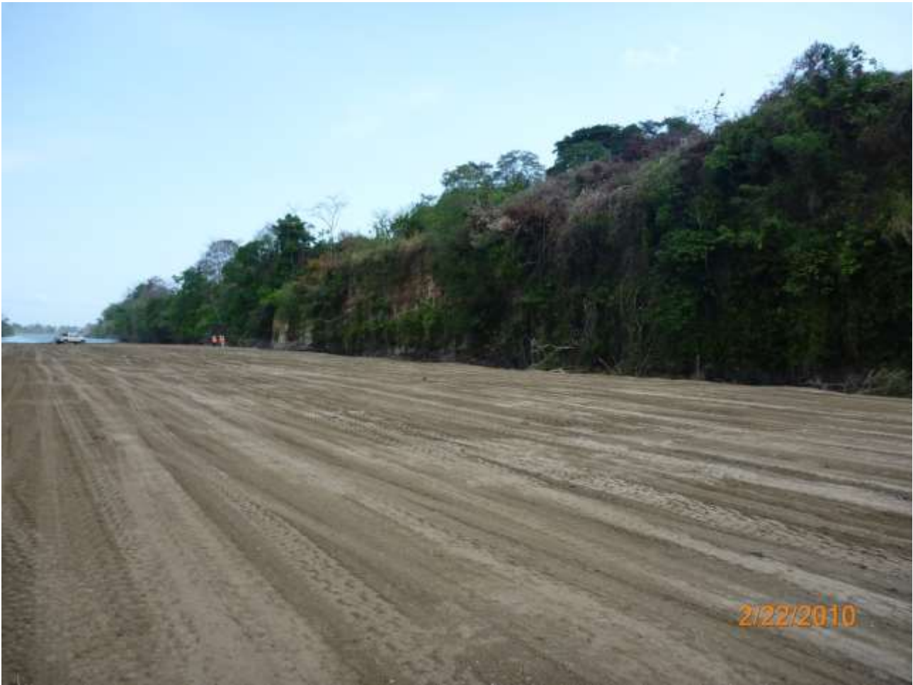
L'area da scavare tutta ripulita. Manca da disboscare le pareti laterali esistenti. Sullo sfondo il lago ancora da svuotare
