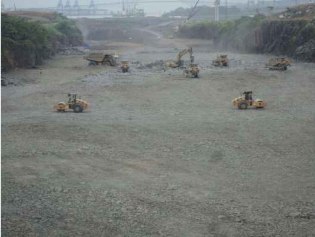
Scavi del 1939 riempiti con basalto a strati debitamente compattato
