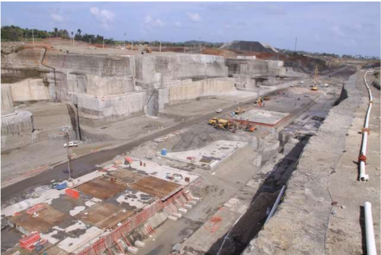
Scavi della Camera bassa praticamente completati nel Febbraio 2012 con i magroni e solette di fondo
