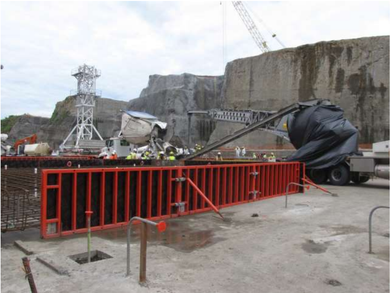
Primo getto strutturale delle solette eseguito il 17 di Luglio 2011.
