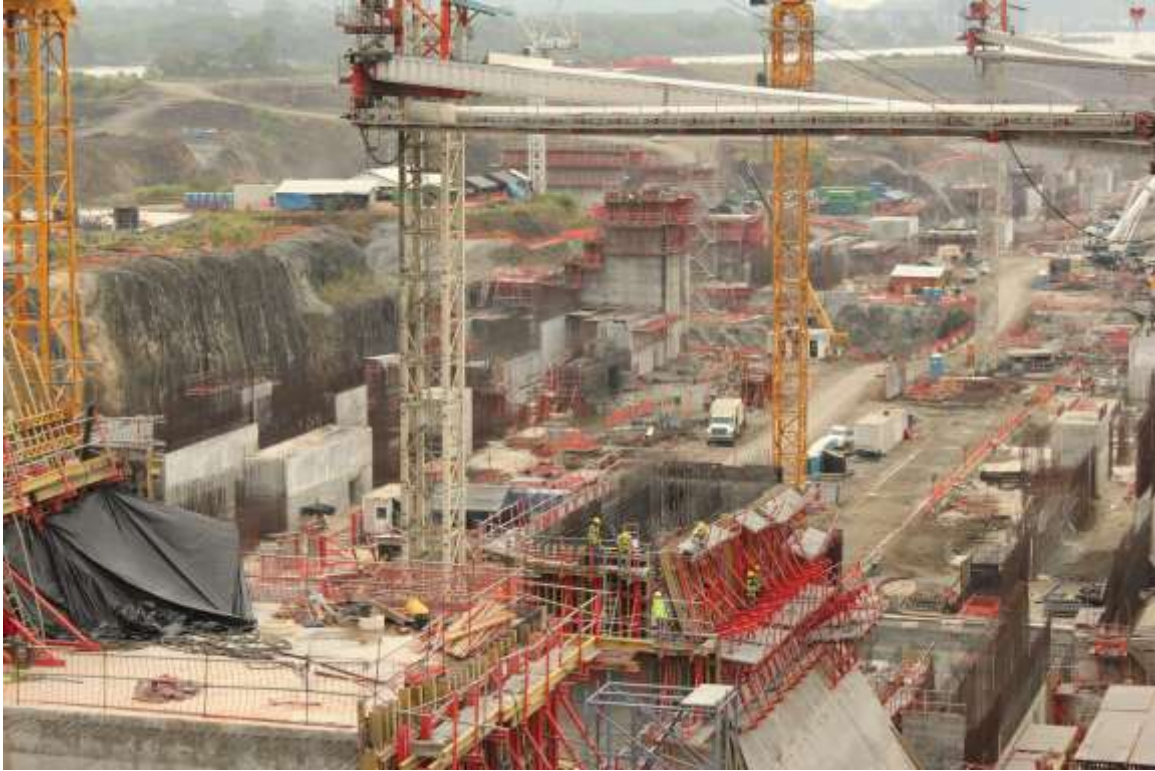
Vista delle gallerie idrauliche dentro i monoliti che riforniranno di acqua il canale via i conduit che collegano il canale stesso con i bacini di accumulo.
