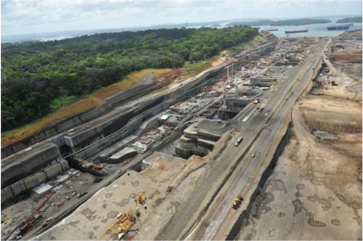
Vista delle opere a metà Febbraio 2012 con gli scavi quasi completamente terminati e le opere in ds iniziate
