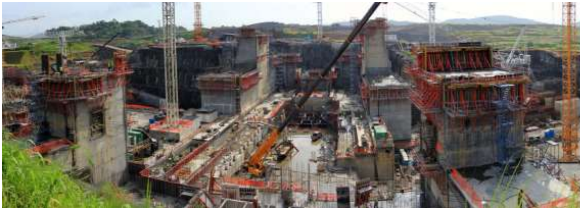
Sopra: Lockheed nr. 2 dove verranno installate due paratoie Sotto: Panoramica delle strutture viste dall'esterno
