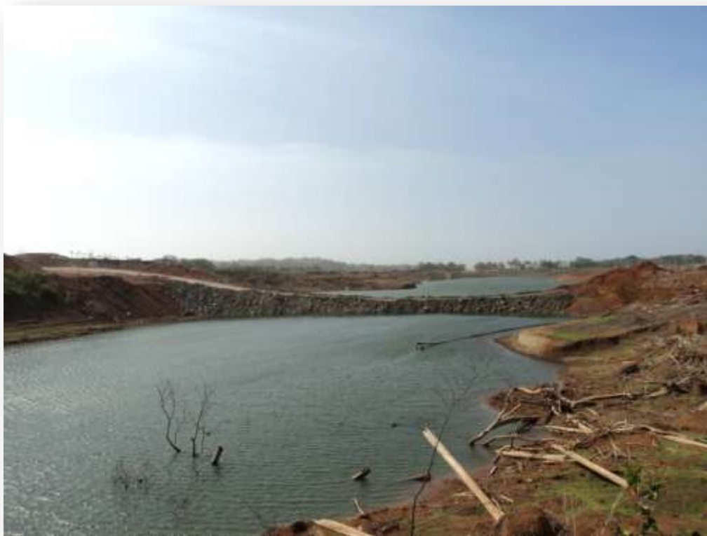
Costruzione del nucleo con il Gatun proveniente dallo scavo del canale di approccio
