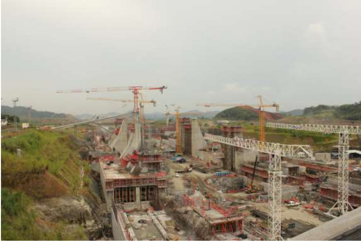
Le aree dietro i muri principali del canale vanno reinterri con circa 6 milioni di metri cubi di Basalto
