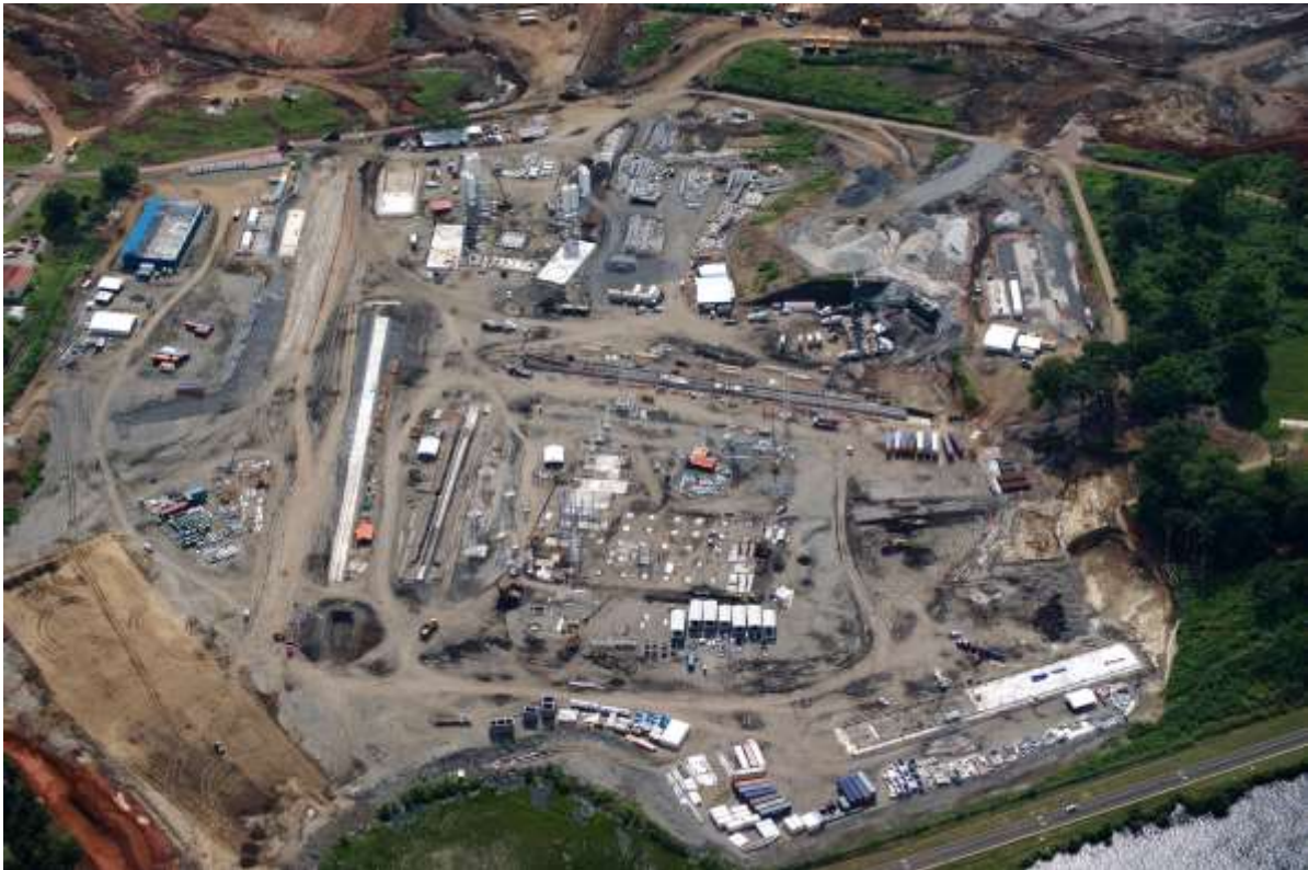
Foto dell'11 Agosto 2010 con l'area industriale che comincia a prendere forma con i lavori civile e montaggi.
