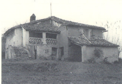
Casa rurale in contrada Annunziata
