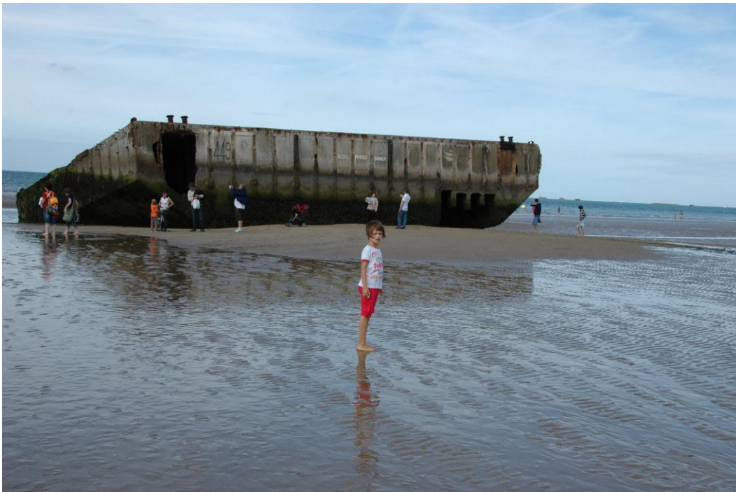
Pezzo di uno dei cassoni galleggianti in calcestruzzo del porto artificiale di Mumberry che si trovano sulla spiaggia di Arromanches
